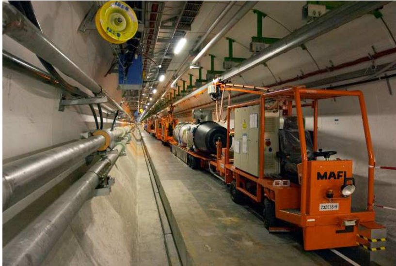
Figura 1.2: Interno della galleria di LHC; i lavori sono attualmente in corso
