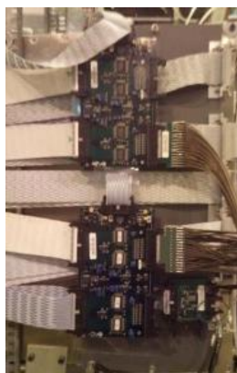
(b.1) Extérieur de la chambre avant amélioration.
