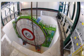
Fig. 3.1 Descente d'une tranche de CMS.
